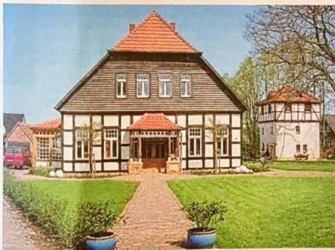
Den alten Meyerhof in Schleddehausen erwarb Volker Eloesser nach dem Verkauf seiner ersten Firma. Inzwischen hat er ihn umfassend saniert.
