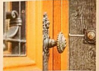
Besonders draußen dunkelt Messing durch Oxidation deutlich nach.
